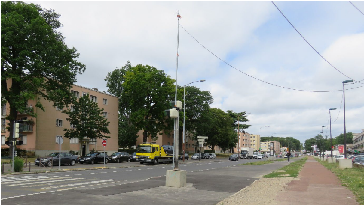
La D986 à Châtenay-Malabry marquant les paysages et les dépréciant aux abords de la cité-jardin de la butte rouge, cette route fait cependant partie des axes offrant des perspectives remarquables sur le territoire (Cf. 1.1.1), source : Even conseil
