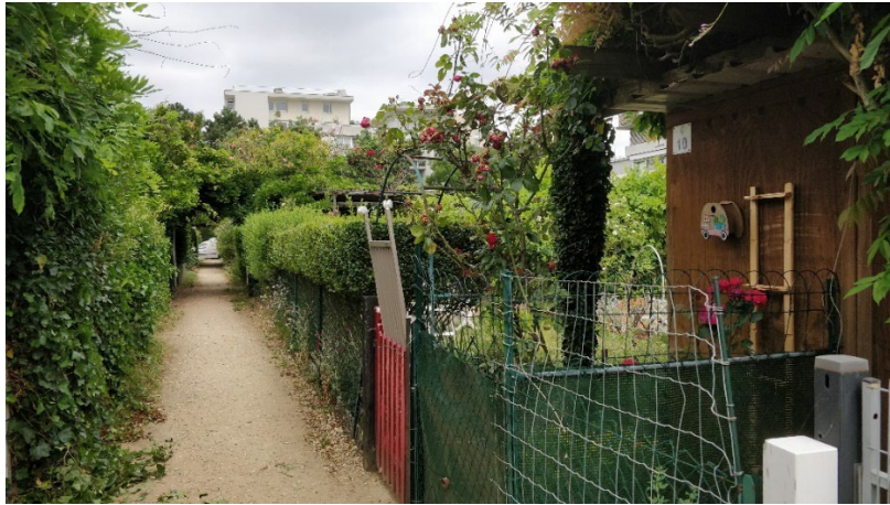
Les jardins familiaux associés aux habitats collectifs de la cité-jardin haute du Plessis-Robinson créant des allées vertes, source : Even conseil
