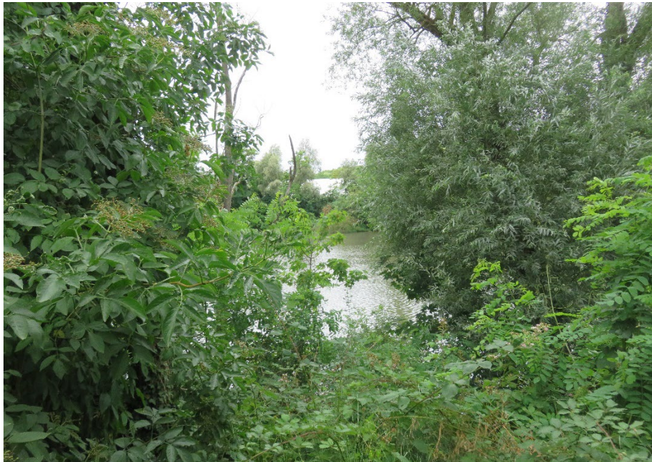
Le bassin de retenue de la Bièvre dissimulé par la végétation, source : Even conseil
