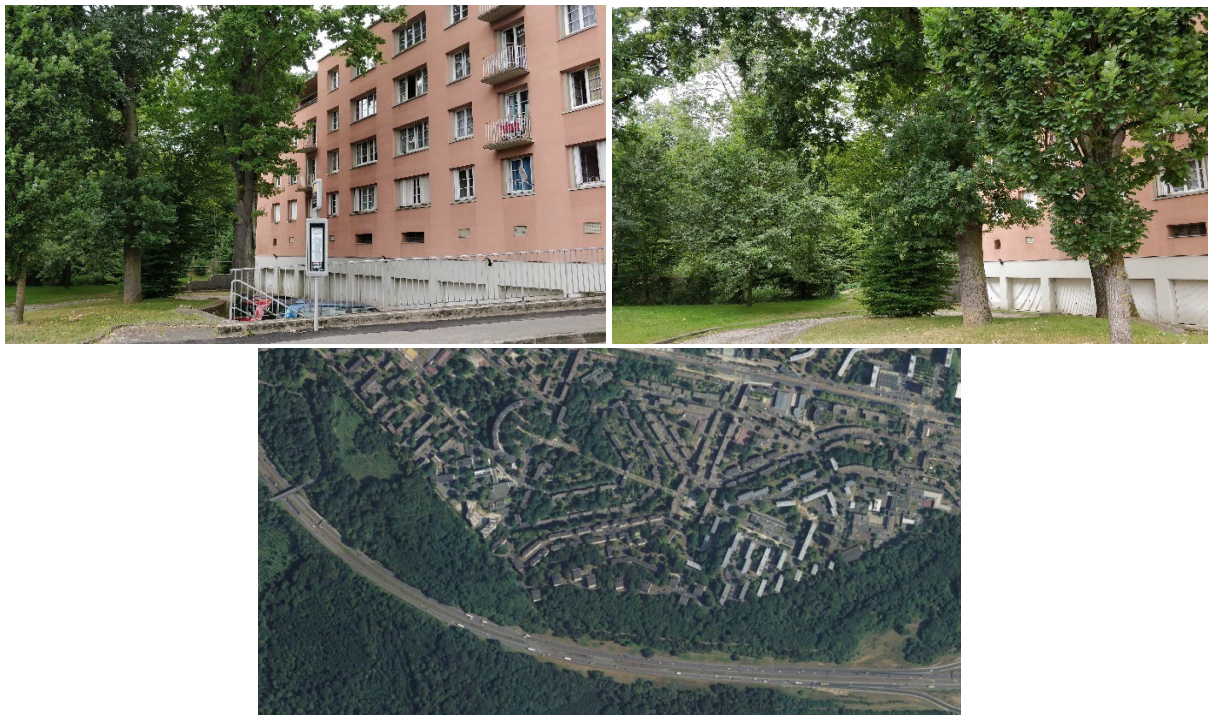
Une transition progressive, au droit de la cité-jardin de la Butte Rouge, entre la forêt de Verrières et le tissu urbain dense de Châtenay-Malabry, source : Even conseil, Géoportail
