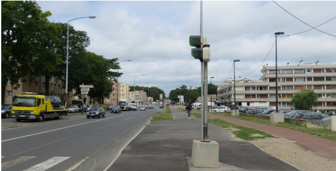
La D986 à Châtenay-Malabry, une emprise difficilement franchissable pour la faune terrestre, source : Even conseil
