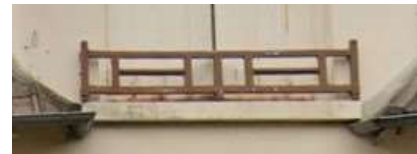
Exemple de garde corps décoratif en béton à conserver
