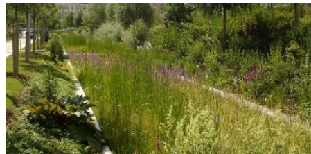
Noue végétalisée (hors territoire)
