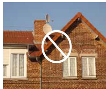
Baies réduites pour recevoir des menuiseries standard
