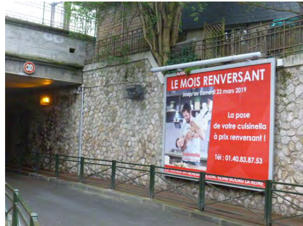
Figure 65 : interdiction sur mur de soutènement.
