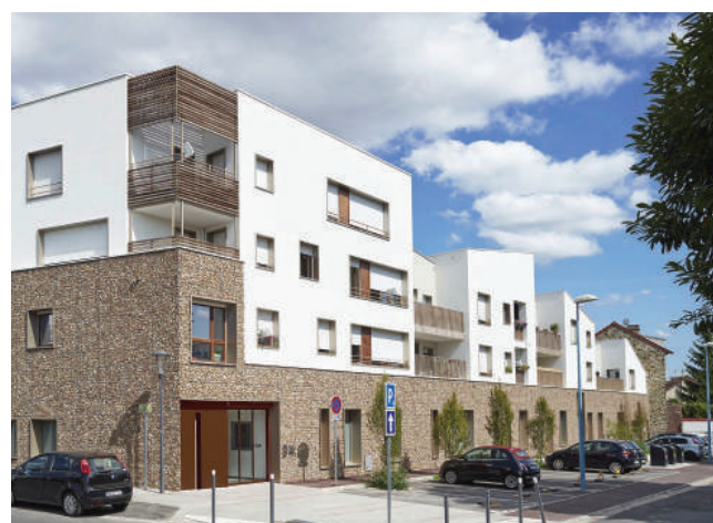
100 Logements à Euaubonne (95) Arch. : Atelier Du Pont
