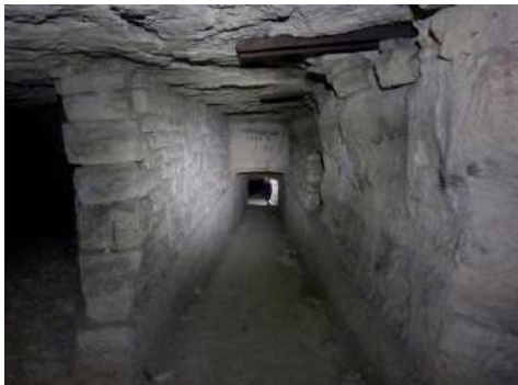
Photo 18 : pente entre 2 étages de carrière – rue de Paris (Photo IGC-2015)
