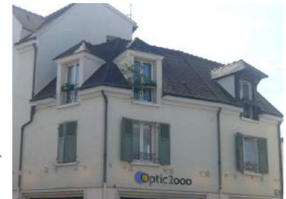
Lucarne jacobine sur toiture en batière
