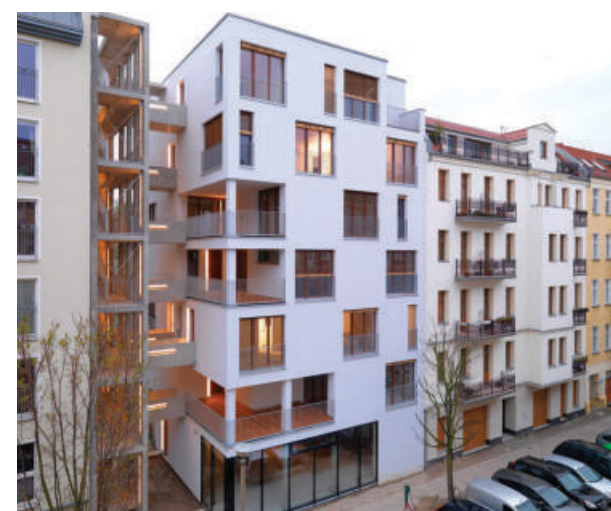
Berlin - Immeuble avec structure porteuse bois Arch. : Agence Kaden-Klingbeil
