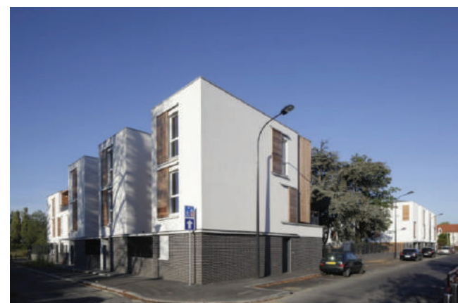
31 Logements à Montfermeil Arch. : Caradec et Risterucci architectes
