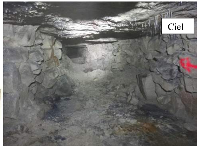
Photo 5 : galerie sous la rue de Paris à Châtillon, exploitation par hagues et bourrages (photo 2015 - JQ-IGC)
