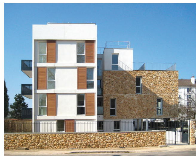
Réutilisation de la meulière de la maison démolie - Les Mureaux Arch. : MAP (Métropole, Architecture, Paysage)
