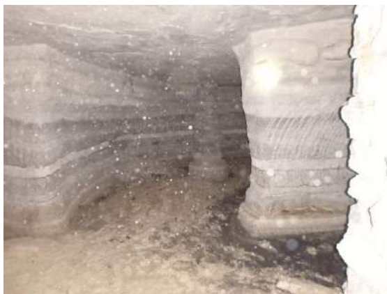
Photo 20 : carrière de gypse, rue Estienne d'Orves – 26m de recouvrement - (Photos JQ, 2018)
