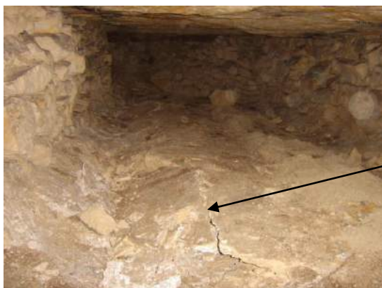
Photo 7 : Tassement et cisaillement du sol sous l'effet de la non-superposition des hagues et de poinçonnement de l'étage moyen par l'étage supérieur – Châtillon (Photo AML-IGC)
