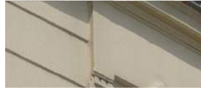
Les joints : Pour les pierres tendres, on préfère les mortiers à base de chaux aérienne ; pour les pierres dures, on préfère les mortiers à base de chaux hydraulique.
