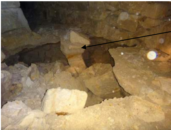
Photo 6 : éclatement du banc séparatif et poinçonnement de ce banc par un pilier à bras de l'étage inférieur à Bagneux (photo AML-IGC)
