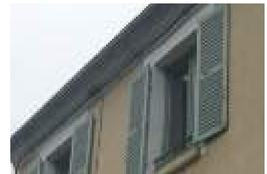
Conserver, ou réinstaller les contrevents en bois
