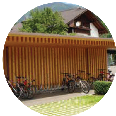
Abris vélo extérieurs protégés
