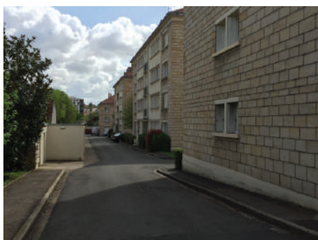
Rue Fontaine Grelot
