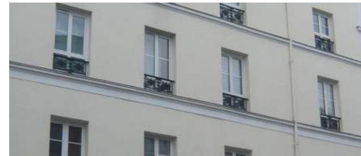
L'enduit plâtre et chaux est traditionnellement lissé
