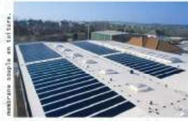
Pose d'une membrane souple
