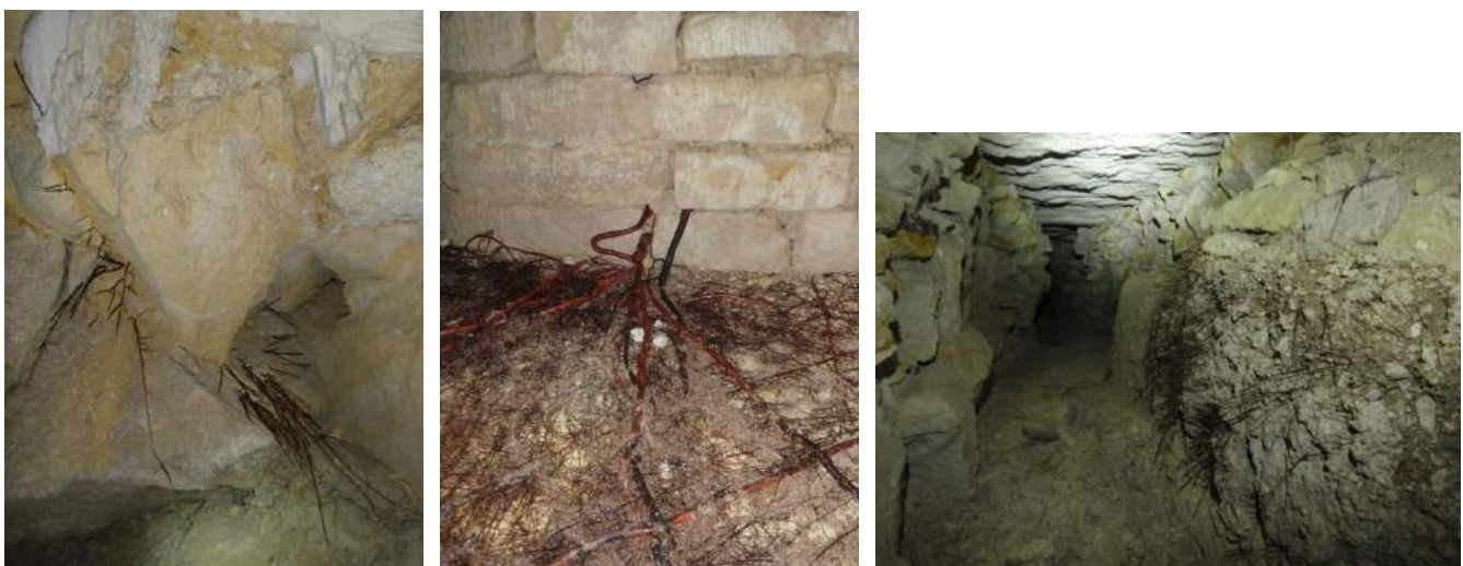
Photo 15 : exemples de racines en carrière – dans un étai de masse, dans un puits ou dans des remblais (photo AML-IGC)
