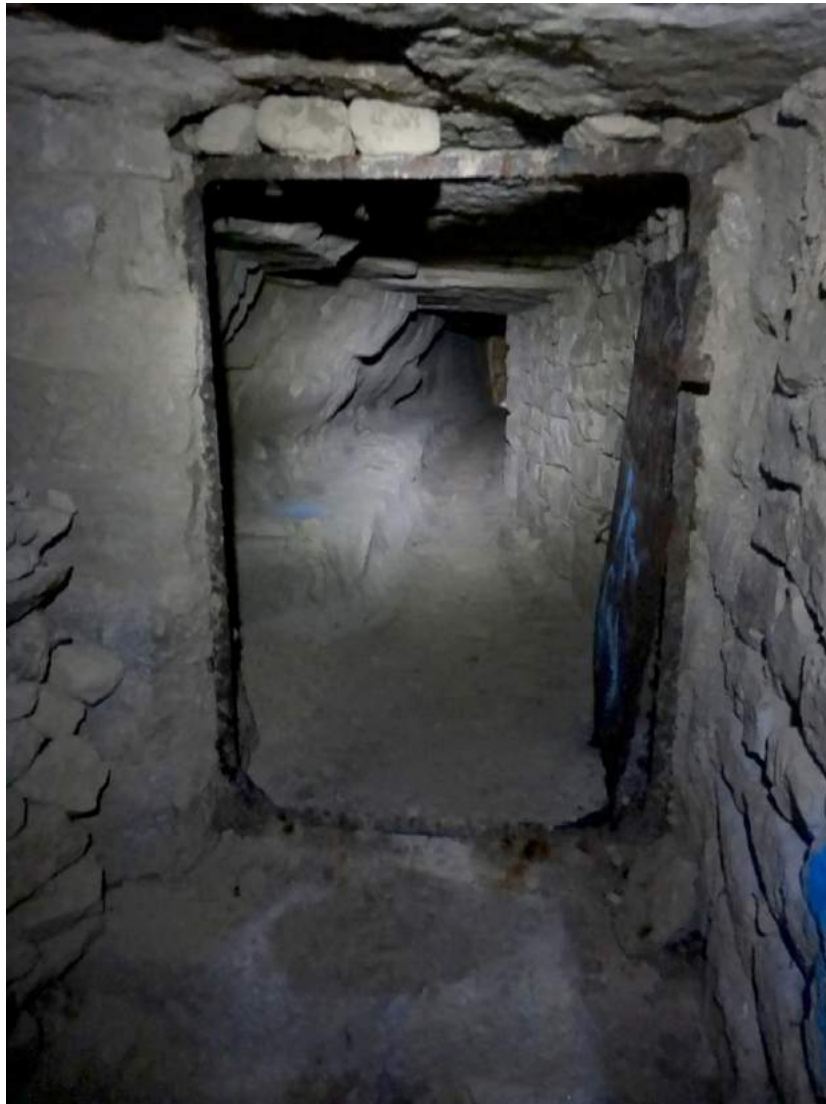
sous la rue de Paris (photo JQ-IGC)
