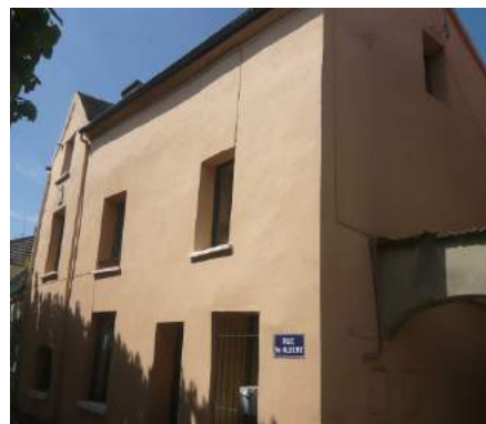
Le PVC : des profils, un aspect et une partition de vitrage très éloignés du dessin d'origine
