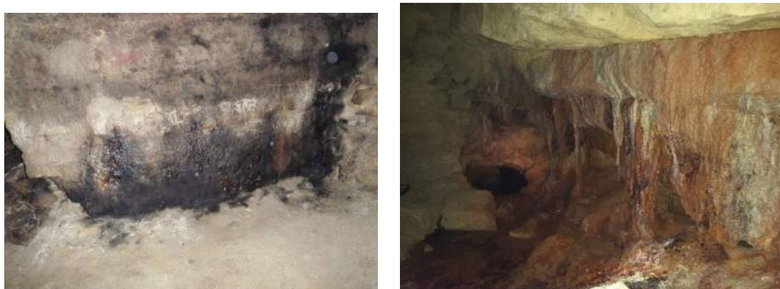
Photo 3 : venues d'eaux polluées sur un front de taille (photo AML-IGC-2012-2013)
