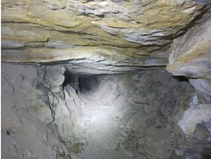
Photo 9 : exemple de ciel de carrière où le Banc de Roche a été exploité, sous la rue de Paris (Photo IGC-AML)
