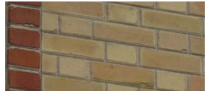
Les briques ne doivent être recouvertes ni par un enduit, ni par une peinture
