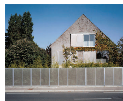
Maison aux Aubrais (Loiret) Arch. : Rémi Pascal + Pierre Bouillon Architectes Prix de la première œuvre
