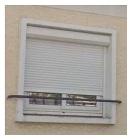
Modèle de volets roulants avec coffret à l'extérieur
