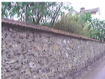
Haut mur en maçonnerie apparente
