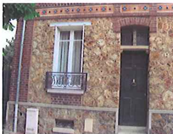
Garde-corps, persiennes et linteau métalliques
