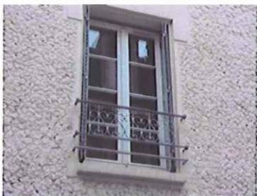
Pose en rénovation de menuiserie PVC
