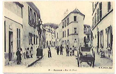
Carte postale ancienne montrant l'emprise du bâti le long de l'îlot du Four (vue vers le Nord)
