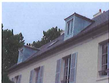
Ardoise naturelle et zinc
