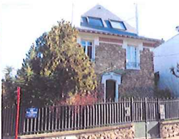
Fenêtres de toit surdimensionnées
