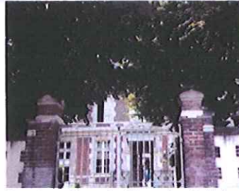
Construction de l'hospice Sainte Marguerite en 1895 par l'architecte Jacques Paul Lequeux
