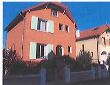
Isolation par l'extérieur
