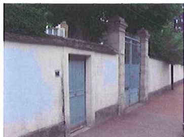
Haut mur en maçonnerie enduite
